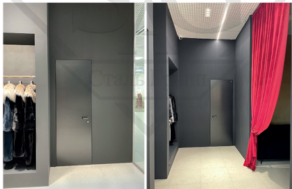
Реализованный проект. Скрытая огнестойкая дверь EI-60. Покраска полотна в тон стен
